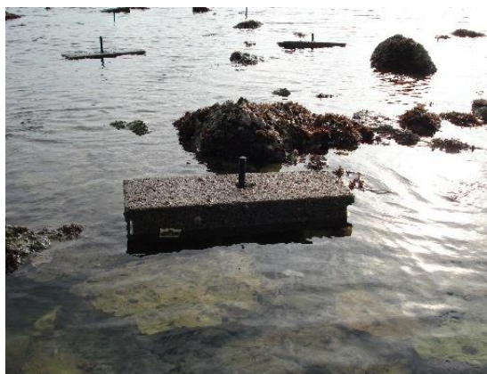
Figure II.2 : champ de blocs artificiels au sein de l'écluse des Vincentes ; fixation des blocs en bûches ou plots en rochers
